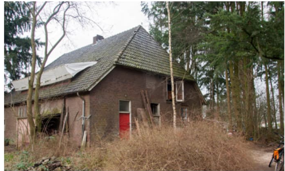
Gebouw 10 op het MOB-complex sectie A
