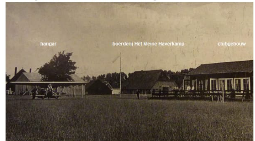
De eerste aanleg van de luchthaven
