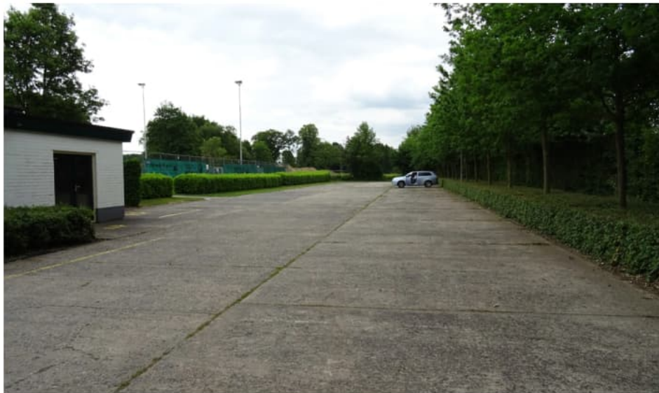
Betonplaten op de oude rollerbaan bij het verenigingscluster
