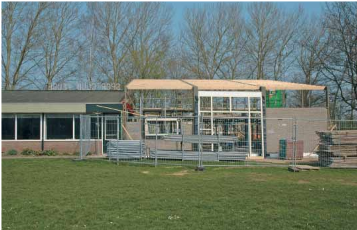
Bouw dorpshuis verloopt voorspoedig.
